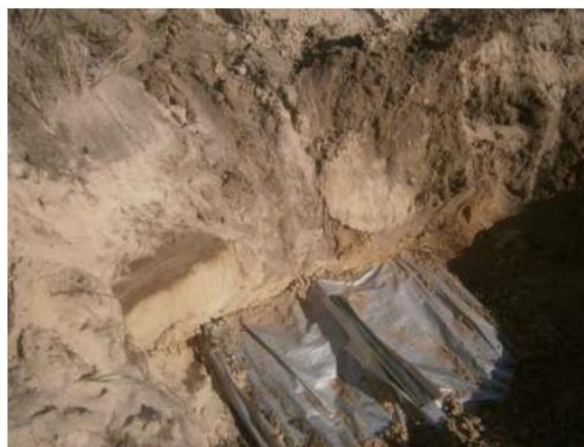
Рисунок 3.2 – Загальний вигляд укладеної труби зрошувача з протифільтраційним екраном
