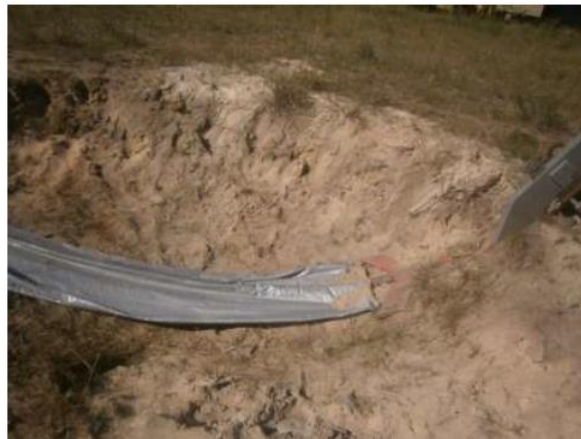
Рисунок 3.1 – Початок протягування труби зрошувача разом із протифільтраційним екраном
