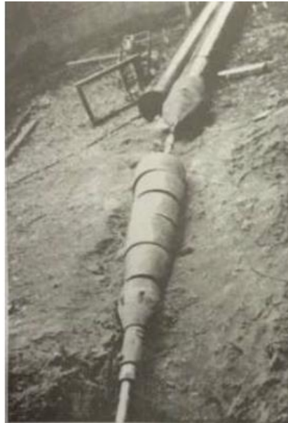
Рисунок 1.1 – Розкатник свердловин РТ-470 із закріпленою у хвостовій частині трубою для протягування в горизонтальну свердловину
