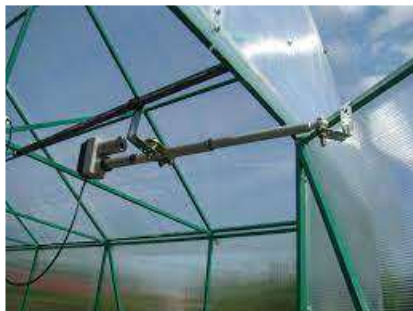
Рис. 11. Електротехнічна система вентиляції.
