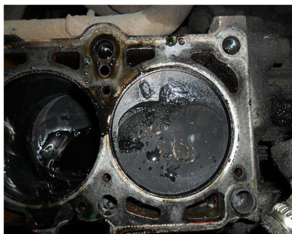
Рисунок 1.4 – Пошкодження головки циліндрів, що виникли внаслідок попадання в камеру згоряння частин зруйнованого сидла клапана, поршня або поршневого кільця
